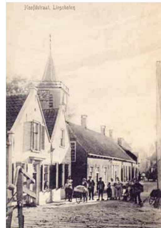
Foto uit 1903. In het tweede pand links oefende Van Ringlesteijn zijn beroep uit. Boven, voor het raam aan de voorkant, zodat er bij daglicht gewerkt kon worden
